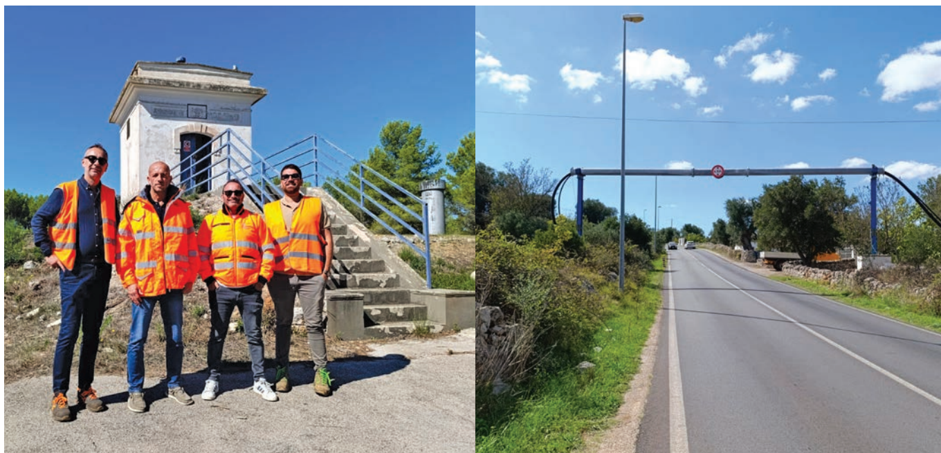
Direzione lavori AQP - Direzione cantieri Rotech. Ponte tubo By-Pass aereo sulla provinciale Ceglie-Ostuni
